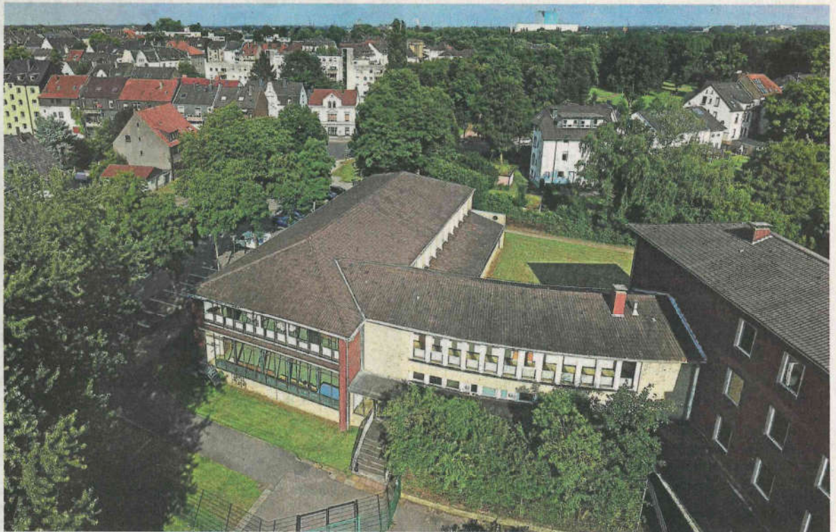
Die alte Turnhalle an der Propst-Hellmich-Promenade, neben der Märkischen Schule, soll einem Neubau weichen.
