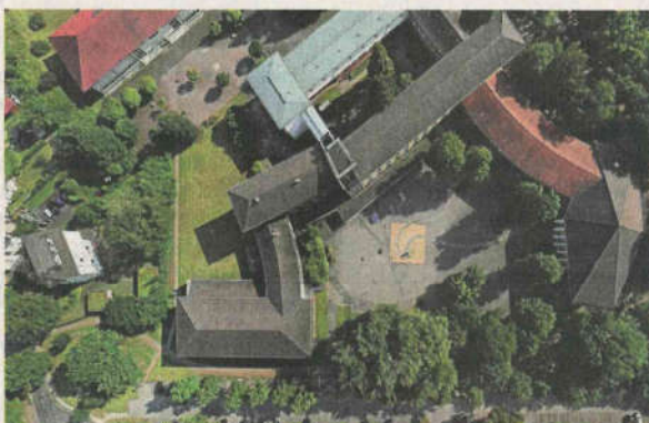
Zehn Bäume werden auf dem Gelände gefällt. Die alte Turnhalle wird abgerissen.
